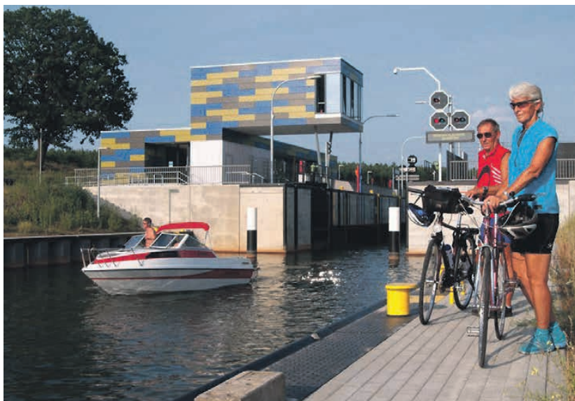
An der Schleuse im Koschener Kanal
